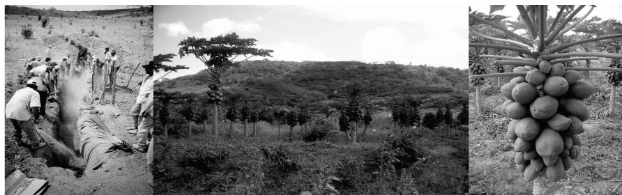
Barragem subterrânea em construção e terminada, produzindo.
